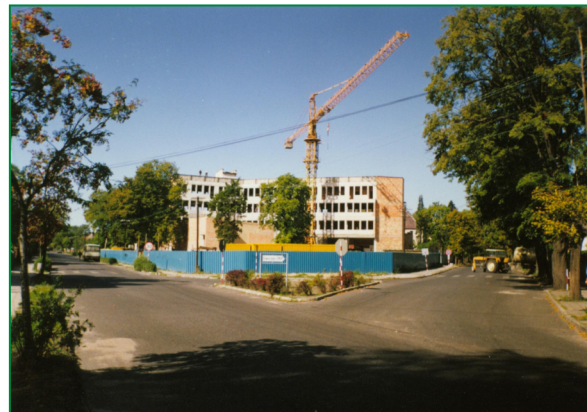
Zdj. 4 Budowa (1991-1993) Izby Celnej w Rzepinie
