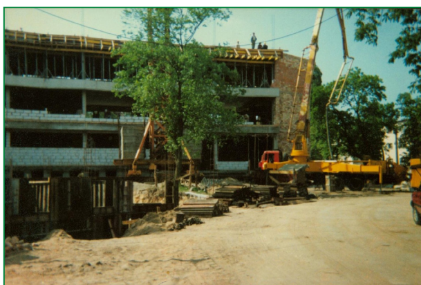
Zdj. 3 Budowa (1991-1993) Izby Celnej w Rzepinie
