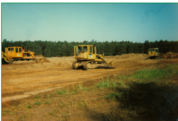
Zdj. 5 Budowa TTOC Świecko
